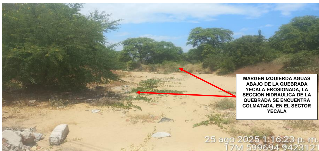
FIGURA N°02: TRAMO CRÍTICO EN LA QUEBRADA YECALA MARGEN IZQUIERDA AGUAS ABAJO EN EL SECTOR YECALA, EN LA CUAL LA SECCION HIDRAULICA SE CUENTRA COLMATADA AFECTANDO TIERRAS AGRICOLAS Y POBLACION, DISTRITO LA MATANZA, PROVINCIA DE MORROPON - PIURA.
